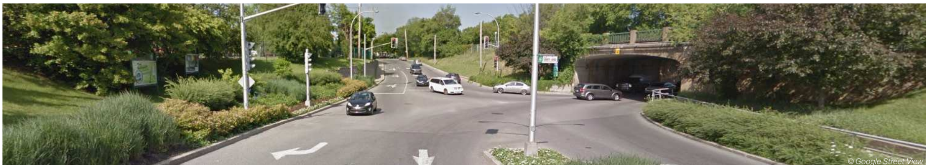
Une des principales entrées au centre-ville : la rue Sicotte et le viaduc de la voie ferrée au-dessus de l'avenue Sainte-Anne.
