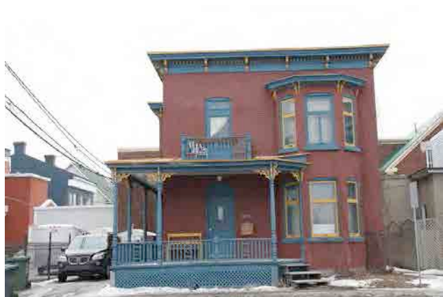
Édifice résidentiel en brique à toit plat, le 1655, rue Dessaulles. IMG_3789.jpg
