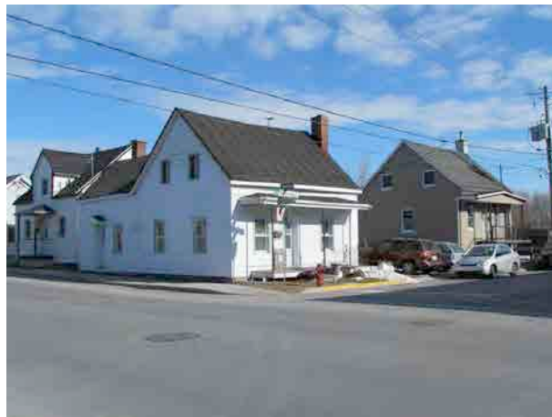
Ensemble d'édifices résidentiels sur la rue Calixa-Lavallée, à l'intersection de l'avenue Vaudreuil. IMG_8239.jpg
