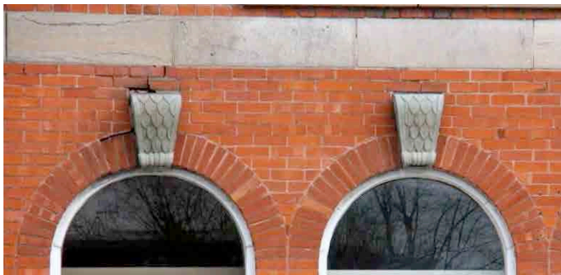
Un détail des fenêtres en plein cintre, des clés décoratives et du bandeau de pierre. IMG_3817.jpg
