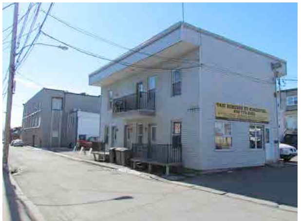
Ensemble d'édifices à fonction mixte sur l'avenue Duclos. IMG_8274.jpg
