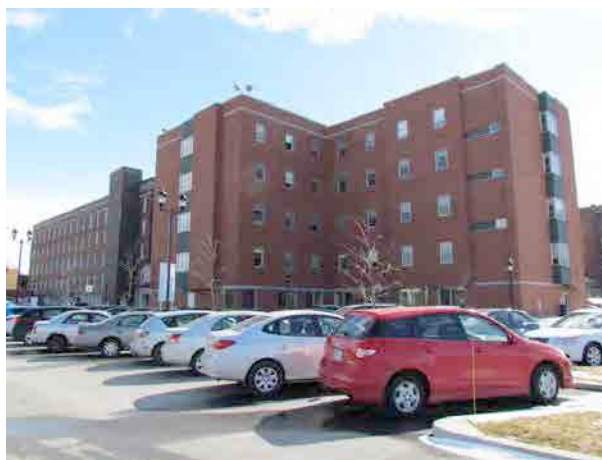
Aile nord-est. IMG_8207.jpg
