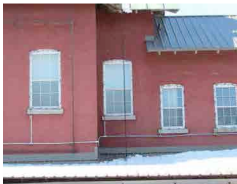
Détail des fenêtres à guillotine. 8136.jpg
