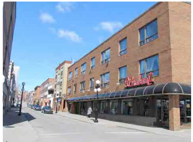
Édifices à fonction mixte à toit plat en brique à trois niveaux à l'intersection de la rue Saint-Antoine et de l'avenue de l'Hôtel-Dieu. IMG_8099.jpg
