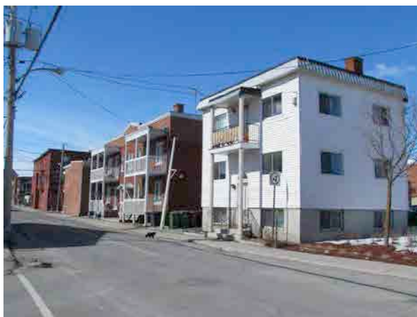
Ensemble d'édifices résidentiels à toit plat sur la rue Marguerite-Bourgeoys. IMG_8080.jpg
