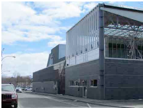
Centre des arts Juliette-Lassonde, façade nord-est. IMG_8125.jpg
