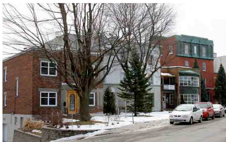
Quatre édifices mitoyens de la rue Girouard Ouest. IMG_3820.jpg
