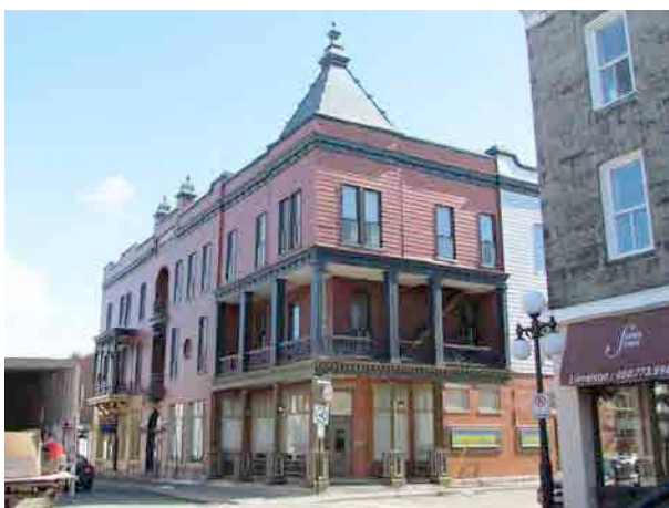
Ensemble d'édifices à fonction mixte à toit plat sur la rue Saint-Antoine, à l'intersection de l'avenue Saint-Simon. Ces édifices datent du début du 20 e siècle. IMG_8065.jpg
