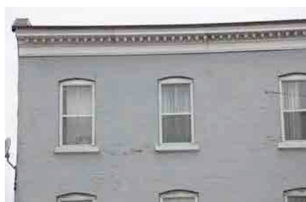
Corniche à denticules et fenêtres à guillotine au 2000-2020, rue des Cascades. IMG_3891.jpg
