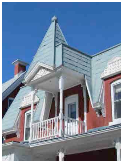
Balcon couvert d'un toit pyramidal et d'un fronton avec aisseliers au 780, avenue de l'Hôtel-de-Ville. IMG_8406.jpg
