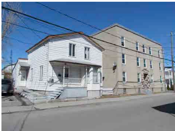
Ensemble d'édifices à logements multiples sur la rue Saint-Antoine. IMG_8345.jpg
