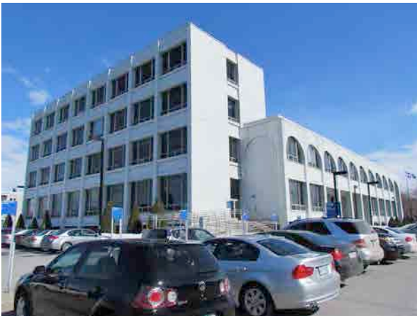
Palais de justice, façade nord-ouest. IMG_8174.jpg
