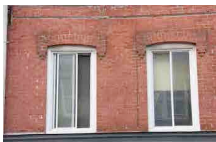
Arcs de brique au 1800-1812, rue des Cascades. IMG_3869.jpg
