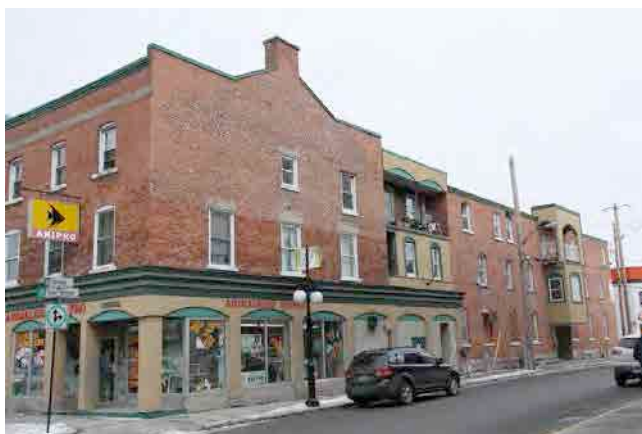
Vitrines commerciales au rez-de-chaussée et fenêtre en saillie prenant la forme d'un oriel (sur deux niveaux) à l'intersection de l'avenue Saint-Simon et la rue Saint-Antoine. IMG_3734.jpg
