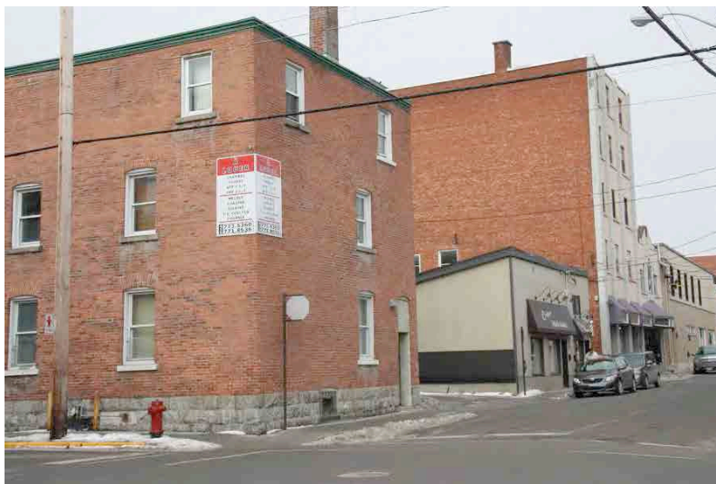
Édifices à fonction mixte à l'intersection de l'avenue Mondor et de la rue Saint-Antoine. IMG_3732.jpg
