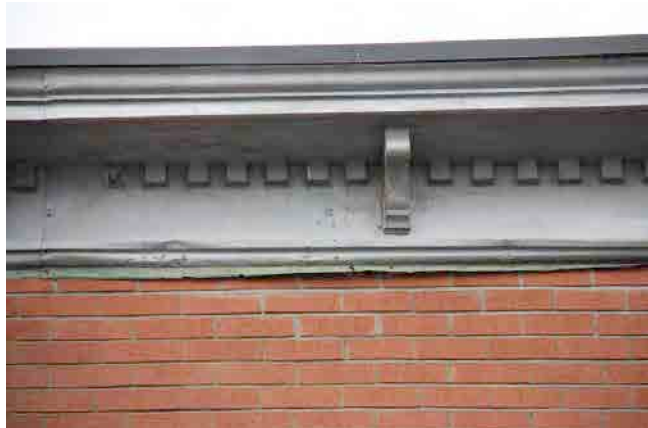
Corniche à consoles et à denticules au 531-545, avenue Mondor ; édifice datant de 1890. IMG_3742.jpg
