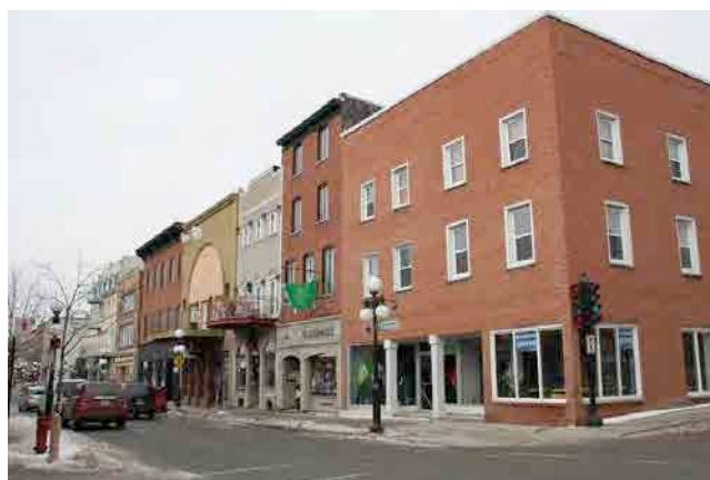
Édifices à fonction mixte sur la rue des Cascades, au coin de l'avenue Mondor. Ces édifices datent de la fin du 19 e siècle. IMG_3737.jpg
