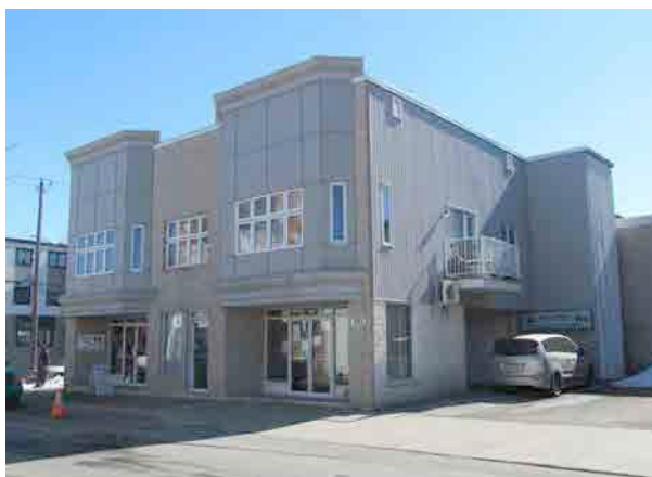
Ensemble d'édifices à fonction mixte sur la rue des Cascades. IMG_8300.jpg
