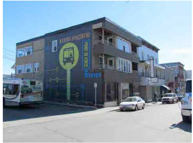
Ensemble d'édifices à fonction mixte sur l'avenue Mondor. IMG_8271.jpg
