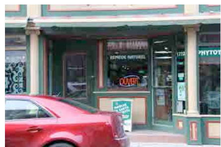
Vitrines commerciales au rez-de-chaussée du 1764-1790, rue des Cascades. IMG_3864.jpg
