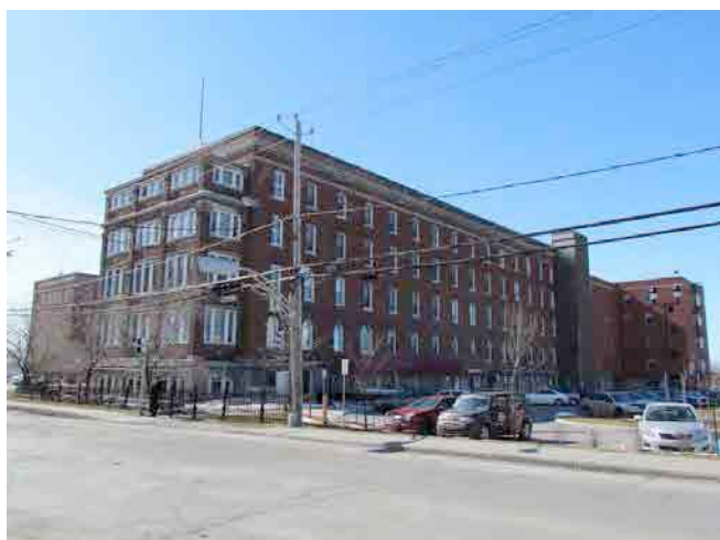
Aile sud-est. IMG_8180.jpg
