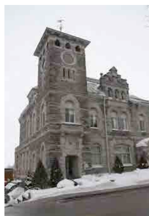
L'ancien bureau poste. IMG_3653.jpg
