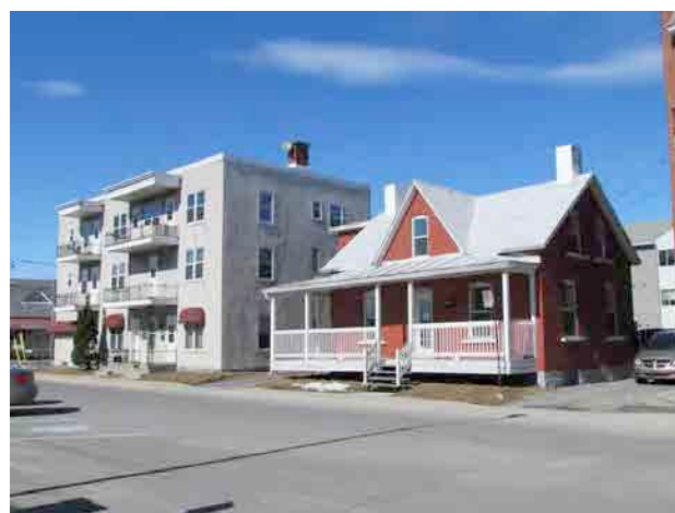
Le 1150 et le 1170-1180, avenue de l'Hôtel-de-Ville. IMG_8431.jpg
