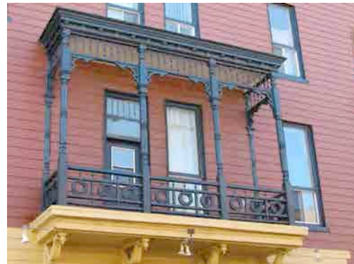
Balcon ornementé d'aisseillers et de lambrequins sur la rue Saint-Antoine. IMG_8073.jpg
