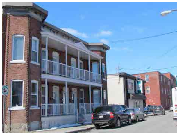
Ensemble d'édifices à fonction mixte à toit plat sur l'avenue Saint-Simon, à l'intersection de la rue Marguerite-Bourgeoys. IMG_8088.jpg
