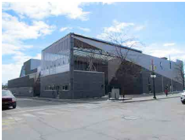
Centre des arts Juliette-Lassonde, façade nord-est. IMG_8124.jpg
