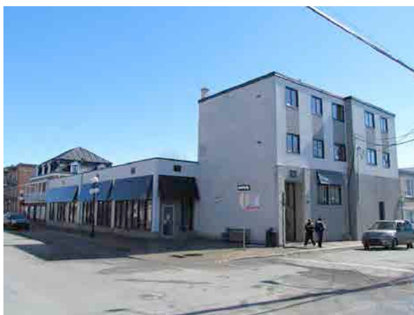
Ensemble d'édifices à fonction mixte sur la rue des Cascades, à l'intersection de l'avenue Robert. IMG_8302.jpg
