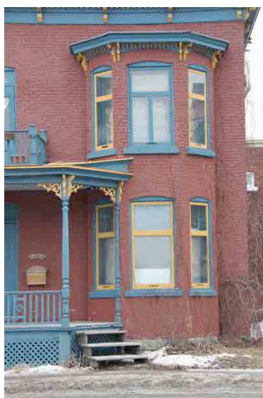
Fenêtre en saillie prenant la forme d'un oriel (sur deux niveaux) au 1655, rue Dessaulles. IMG_3791.jpg
