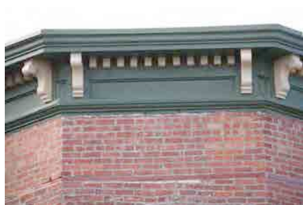
Corniche à consoles et à denticules au 1700-1712, rue des Cascades. IMG_3861.jpg
