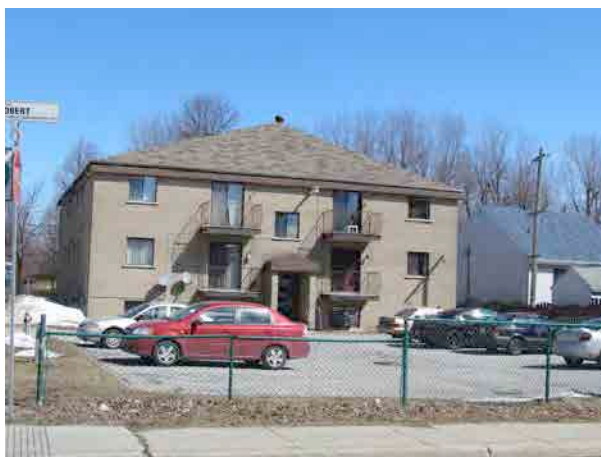
Ensemble d'édifices à logements multiples sur la rue Saint-Antoine. IMG_8348.jpg
