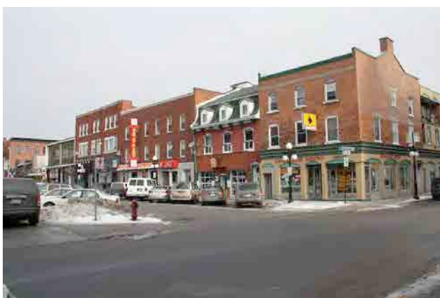
Ensemble d'édifices commerciaux ou à fonction mixte en brique à trois niveaux sur l'avenue Saint-Simon. IMG_3716.jpg
