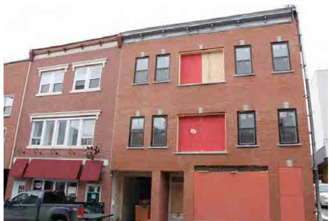
Édifices à fonction mixte en brique à toit plat datant de la fin du 19 e siècle, le 515-525 et le 531-545, avenue Mondor. IMG_3741.jpg
