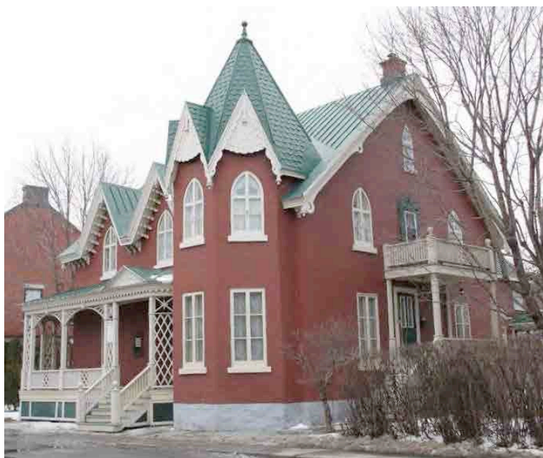
Le 1250-1280, rue Girouard Ouest, un exemple du style d'inspiration néogothique. IMG_3834.jpg
