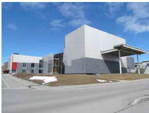
Centre des arts Juliette-Lassonde, façade sud-ouest. IMG_8127.jpg
