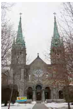
Façade principale de la cathédrale. IMG_4008.jpg
