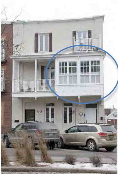
Édifice résidentiel de type triplex, à toit plat à trois niveaux d'occupation avec logette (cercle) au 1653-1661, rue Girouard Ouest. IMG_3747.jpg
