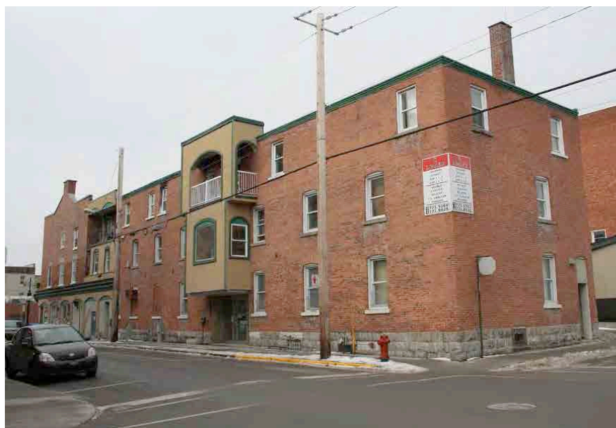
Édifice à fonction mixte en brique à toit plat sur la rue Saint-Antoine. IMG_3733.jpg
