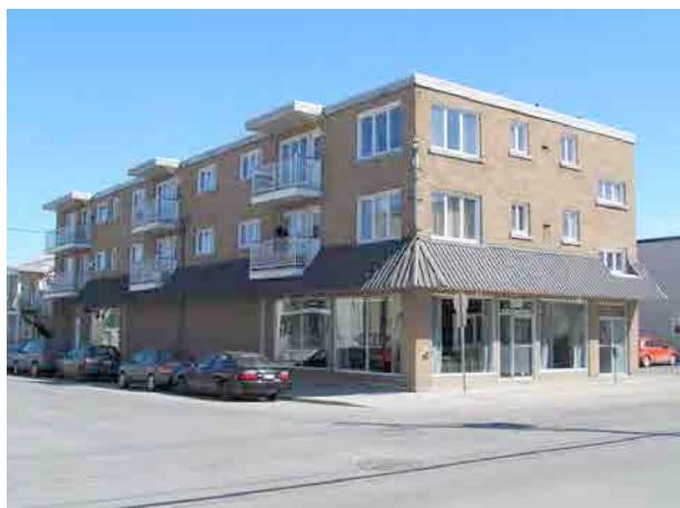
Ensemble d'édifices à fonction mixte sur la rue Calixa-Lavallée, à l'intersection de l'avenue de la Concorde Nord. IMG_8379.jpg
