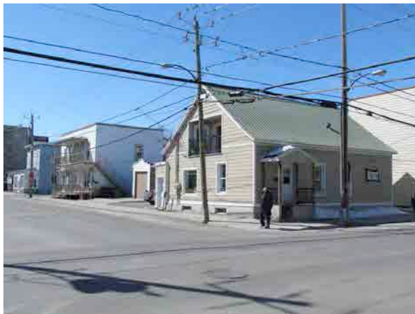
Ensemble d'édifices résidentiels sur la rue Calixa-Lavallée, à l'intersection de l'avenue de la Concorde Nord. IMG_8377.jpg
