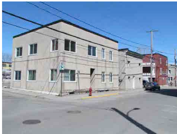
Ensemble d'édifices à logements multiples sur la rue Saint-Antoine. IMG_8331.jpg
