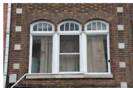
Fenêtres triples avec imposte à arc surbaissé au 1645-1685, rue des Cascades. IMG_3903.jpg
