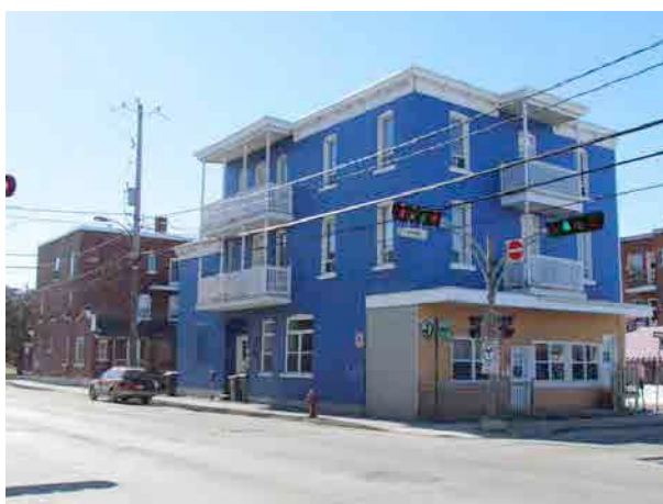
Ensemble d'édifices à fonction mixte à toit plat sur la rue Dessaulles, à l'intersection de l'avenue Laframboise. IMG_8457.jpg
