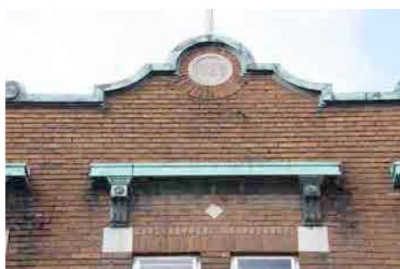
Mur parapet au 1648-1660, rue des Cascades. IMG_3854.jpg
