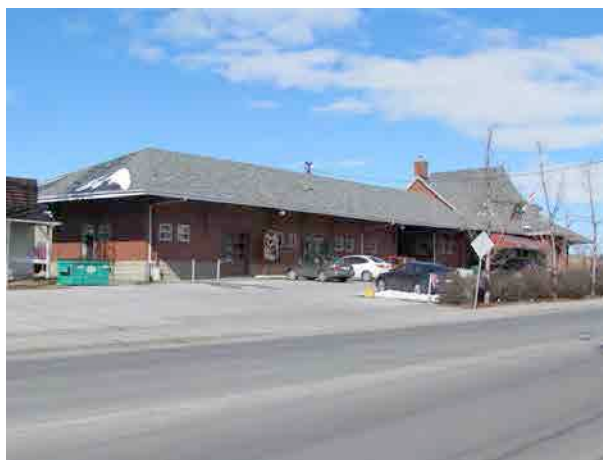
Gare ferroviaire de Saint-Hyacinthe, façade sud. IMG_8212.jpg
