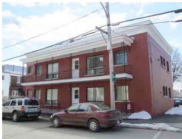
Le 285-295, avenue Saint-François. IMG_8131.jpg
