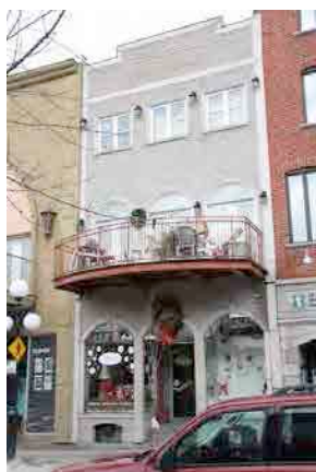
Exemple d'édifice à fonction mixte à toit plat et à trois niveaux, le 1450-1460, rue des Cascades. IMG_3738.jpg
