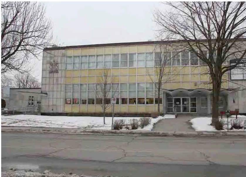
Façade sud-est de l'édifice de Postes Canada. IMG_3933.jpg
