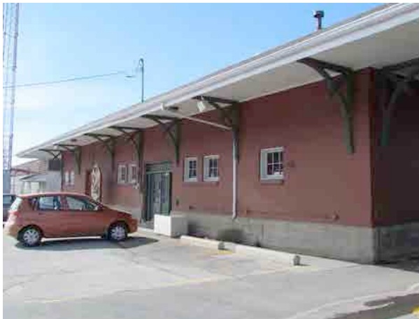
Gare ferroviaire de Saint-Hyacinthe, façade sud. IMG_8221.jpg
