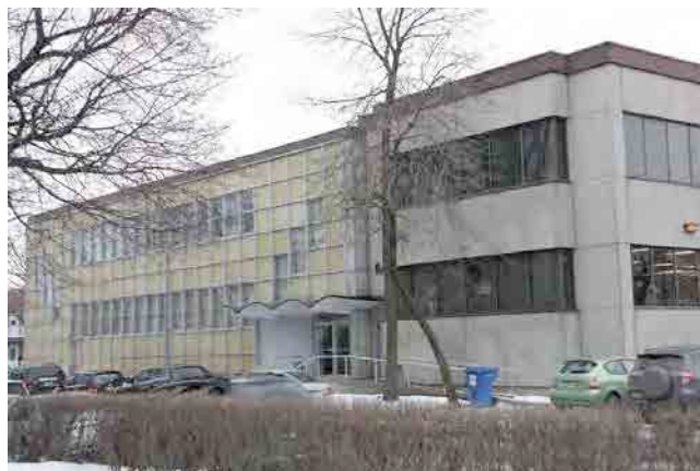
Façade nord-est de l'édifice de Postes Canada. IMG_3931.jpg
