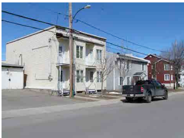
Ensemble d'édifices à logements multiples sur la rue Saint-Antoine. IMG_8353.jpg
