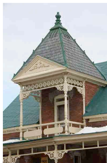
Balcon couvert d'un toit pyramidal et d'un fronton avec lambrequin et aisseliers au 900, avenue Sainte-Anne. IMG_3803.jpg
