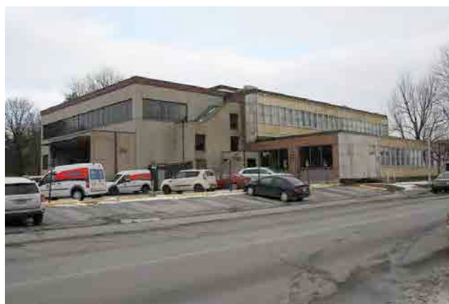
Façade ouest de l'édifice de Postes Canada. IMG_3929.jpg
