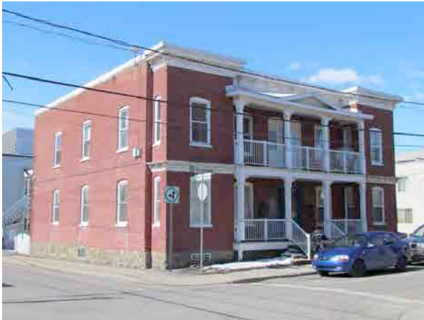
Le 305-307, avenue Saint-François. IMG_8091.jpg
