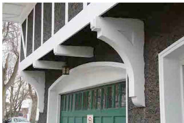
Un détail des consoles du garage et des chevrons apparents, des composantes très rares pour ce type de bâtiment. IMG_3977.jpg
