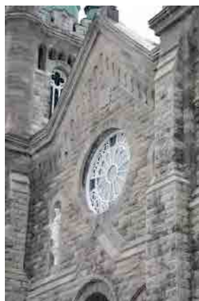
Détail de la façade et de la rosace. IMG_3992.jpg
