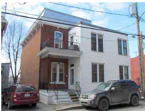
Le 285, avenue Saint-François. IMG_8135.jpg
