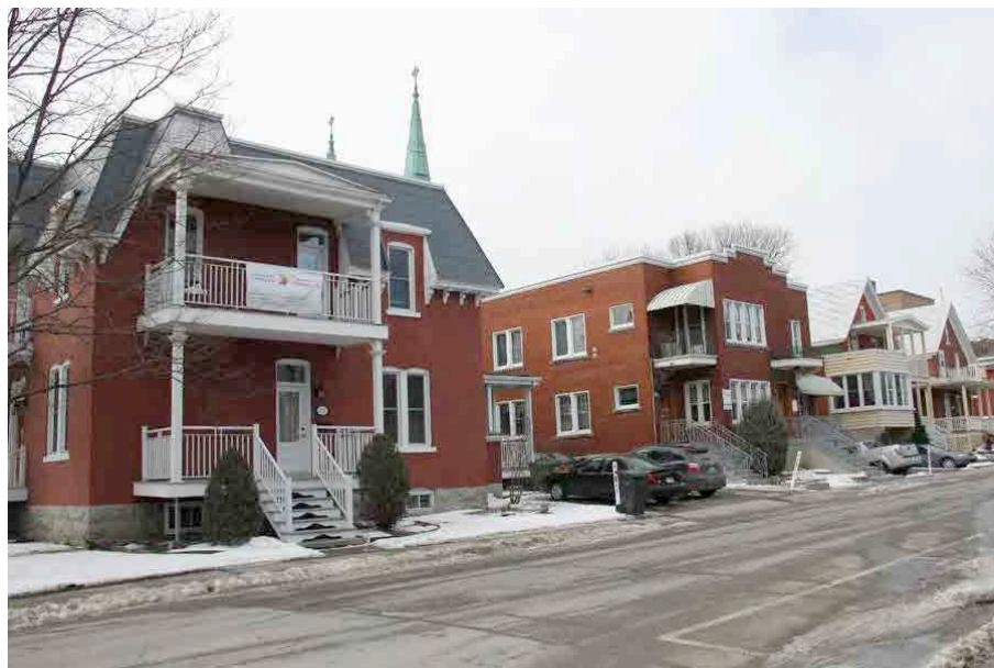
Édifices résidentiels en brique à toit plat et de type vernaculaire américain sur l'avenue Sainte-Anne. IMG_3813.jpg
