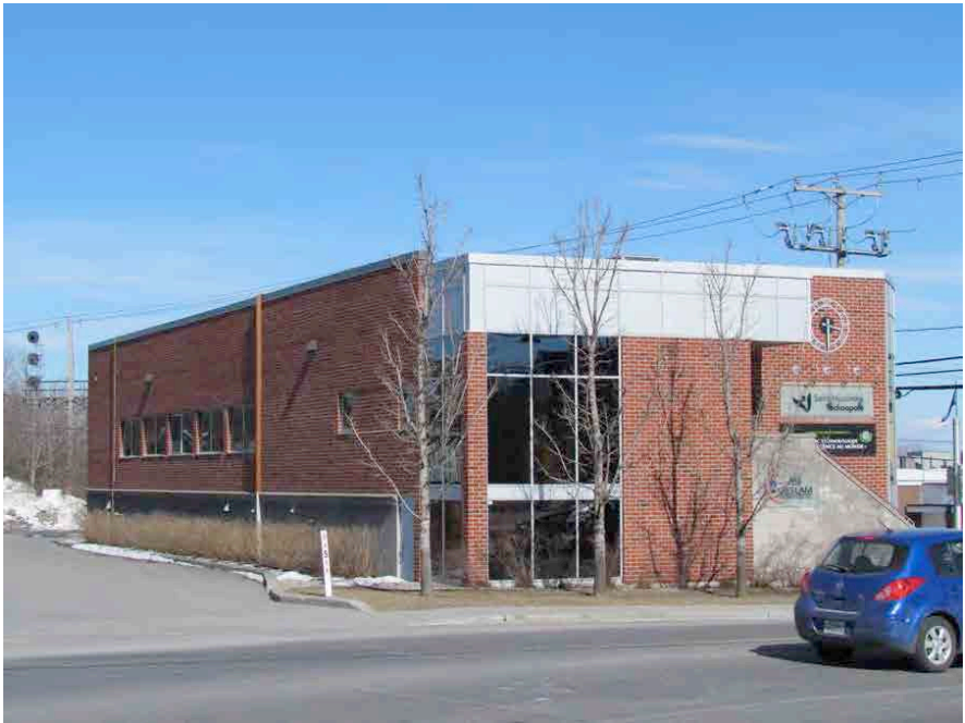
Le 1000, rue Girouard Ouest. IMG_8470.jpg
