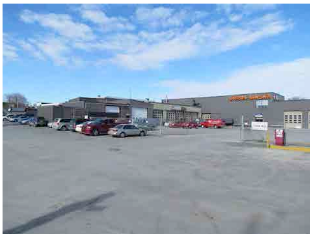
Ensemble d'édifices à fonction industrielle sur la rue des Cascades. IMG_8252.jpg
