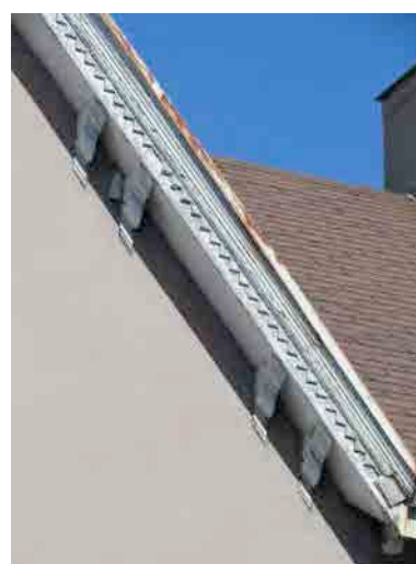
Corniche à consoles et à denticules au 970-990, avenue Laframboise. IMG_8455.jpg
