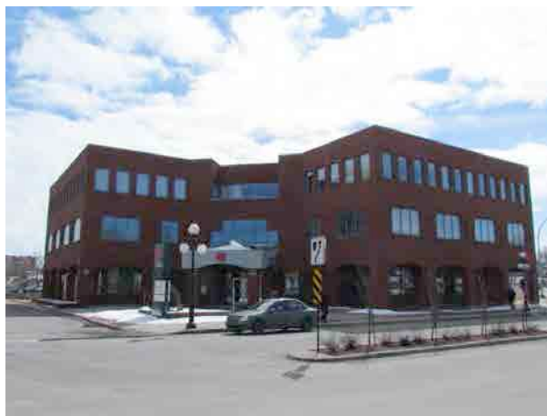
Le 1935-1955, rue des Cascades, façade nord. IMG_8110.jpg
