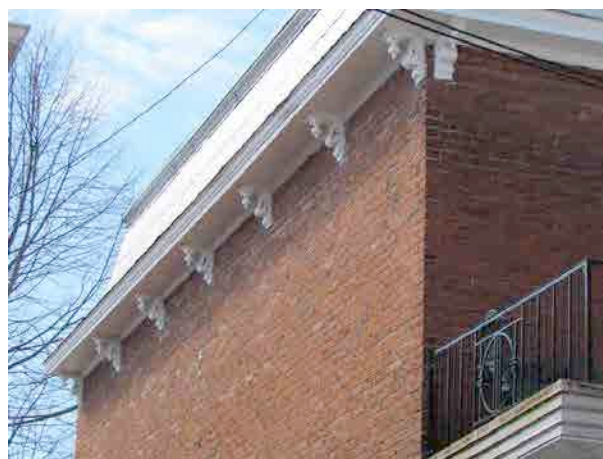
Détail de la corniche à consoles du 285, avenue Saint-François. IMG_8136.jpg
