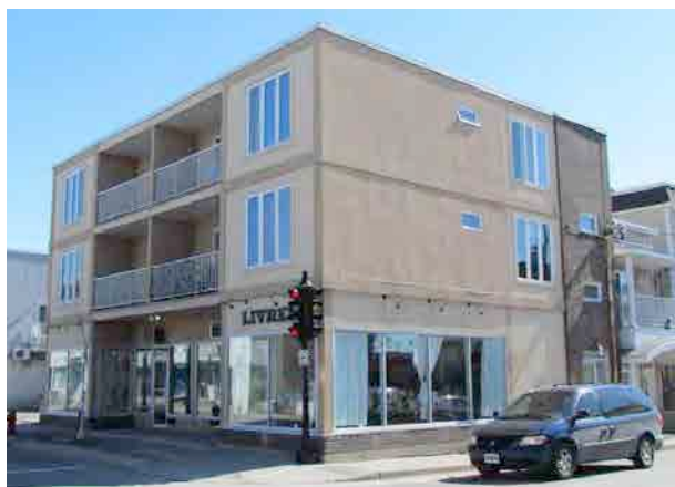
Ensemble d'édifices à fonction mixte sur la rue des Cascades, à l'intersection de l'avenue de la Concorde Nord. IMG_8298.jpg
