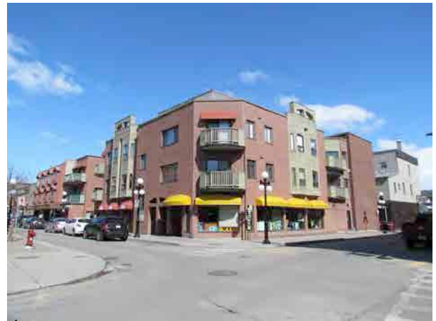
Édifices à fonction mixte à toit plat en brique à trois niveaux à l'intersection de la rue Saint-Antoine et de l'avenue Sainte-Anne. IMG_8095.jpg
