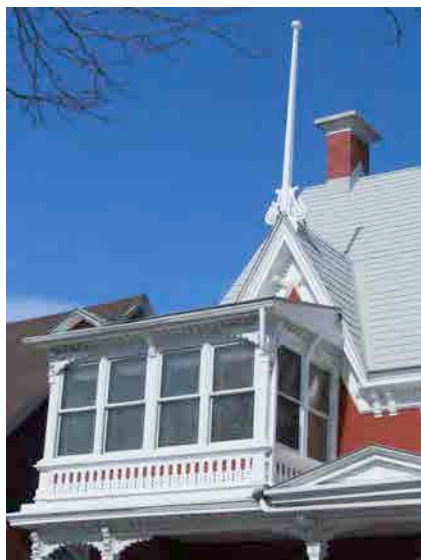
Balcon fermé, corniche à consoles et épi au 800-810, avenue de l'Hôtel-de-Ville. IMG_8413.jpg
