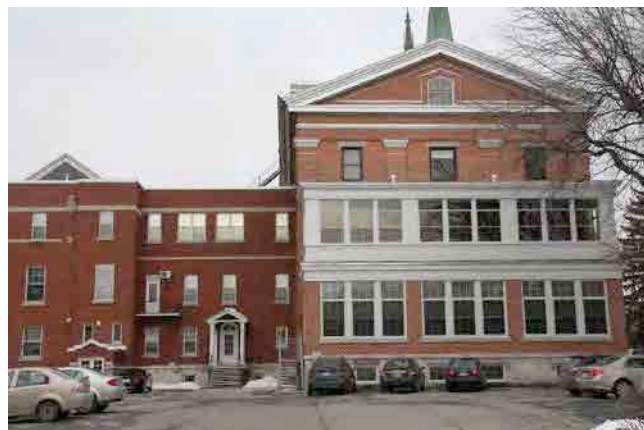
Élévation latérale de l'évêché de Saint-Hyacinthe. IMG_3974.jpg
