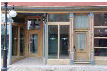
Vitrines commerciales au rez-de-chaussée du 1882-1890, rue des Cascades. IMG_3871.jpg
