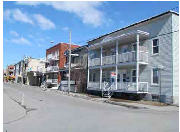
Édifices résidentiels à toit plat à deux et à trois niveaux sur l'avenue Sainte-Anne. IMG_8093.jpg
