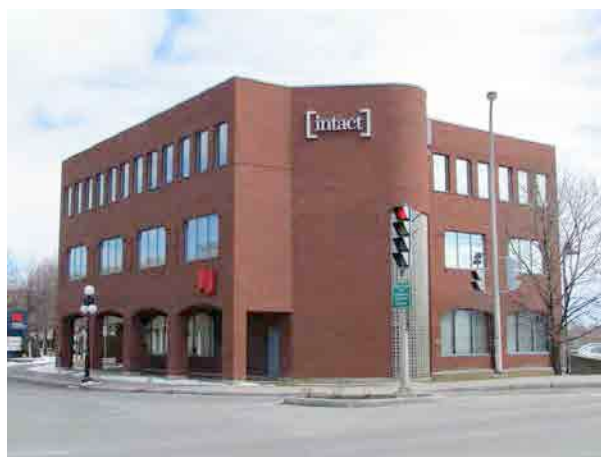
Le 1935-1955, rue des Cascades, façade ouest. IMG_8104.jpg
