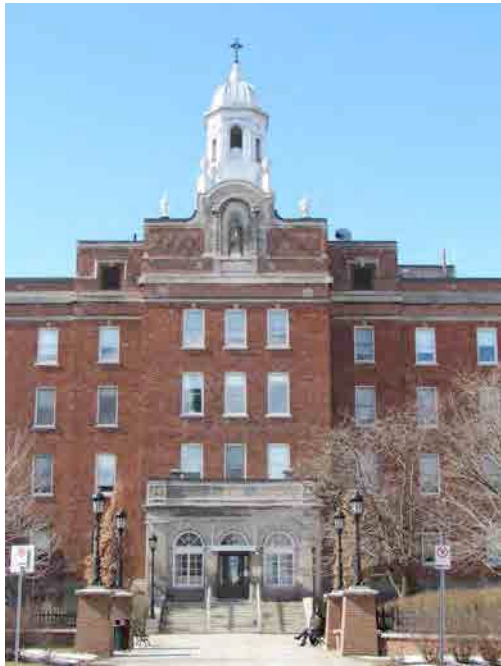
Avant-corps de la façade principale. IMG_8188.jpg
