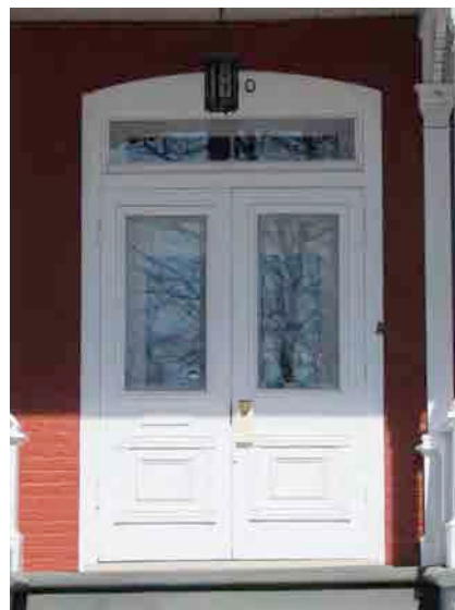
Porte à double battant au 800-810, avenue de l'Hôtel-de-Ville. IMG_8415.jpg
