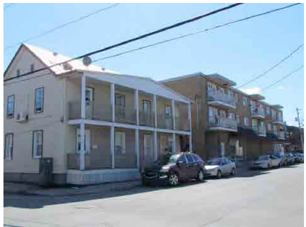
Ensemble d'édifices résidentiels sur la rue Calixa-Lavallée, à l'intersection de l'avenue Robert. IMG_8375.jpg
