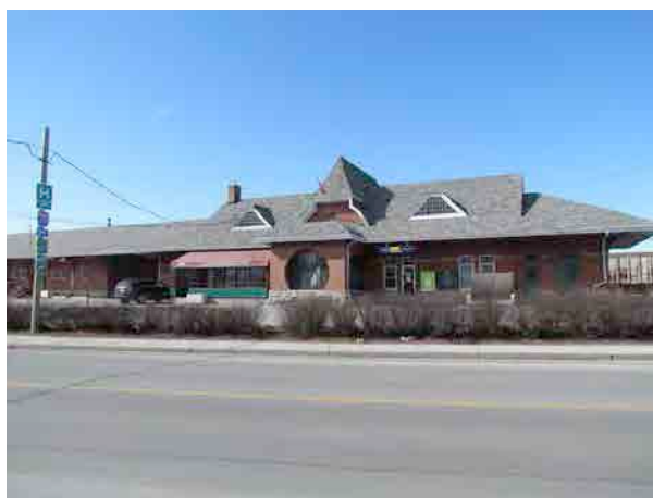
Gare ferroviaire de Saint-Hyacinthe, façade sud. IMG_8218.jpg
