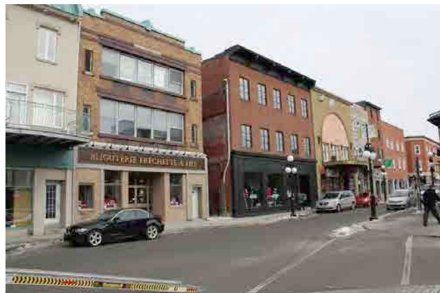
Ensemble d'édifices commerciaux ou à fonction mixte en brique et à toit plat sur la rue des Cascades. IMG_3736.jpg
