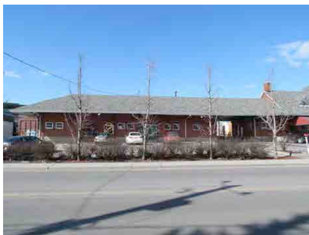
Gare ferroviaire de Saint-Hyacinthe, façade sud. IMG_8213.jpg
