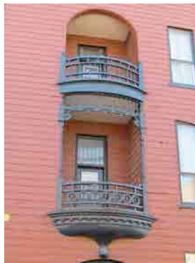
Balcons superposés sur la rue Saint-Antoine. IMG_8072.jpg
