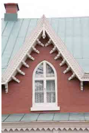
Un détail d'une fenêtre en arc brisé et de la corniche à consoles. IMG_3838.jpg
