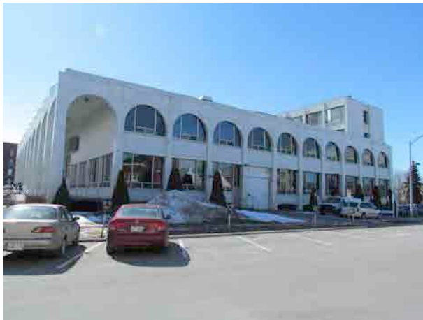
Palais de justice, façade est. IMG_8167.jpg
