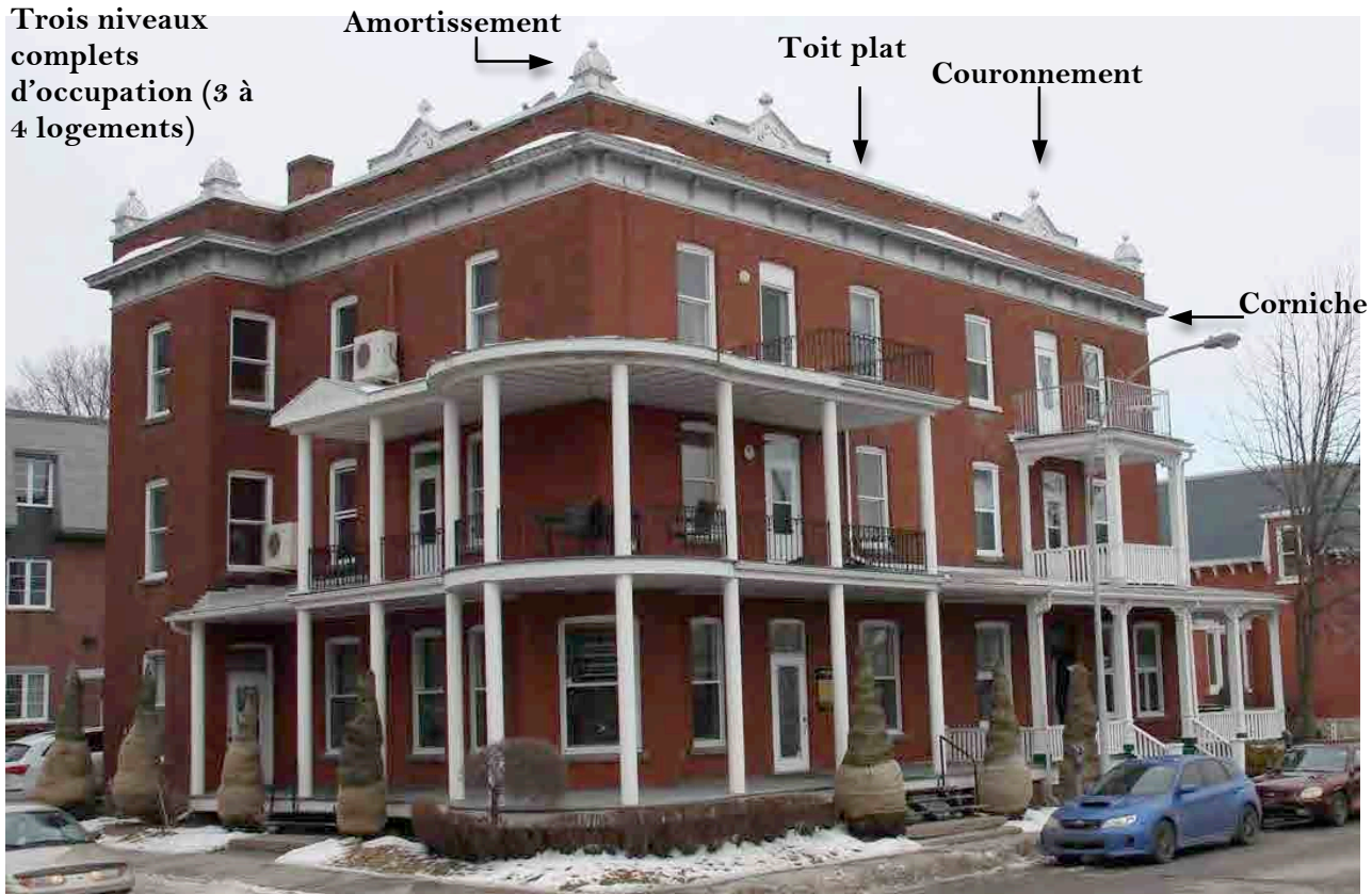
Le 1780-1784, rue Girouard Ouest. IMG_3756.jpg
