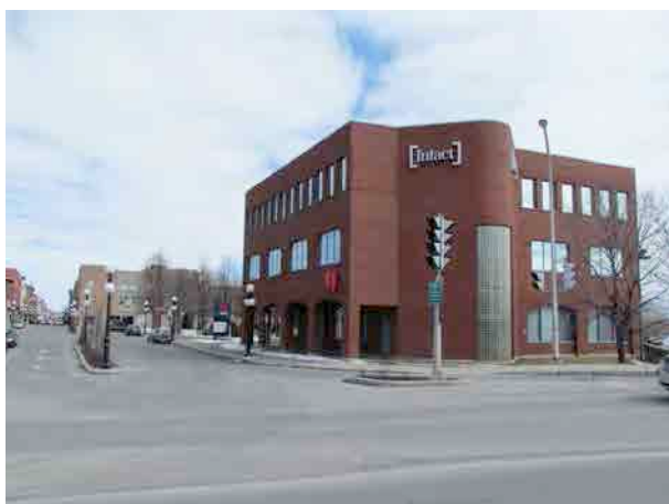
Le 1935-1955, rue des Cascades, façade ouest. IMG_8105.jpg
