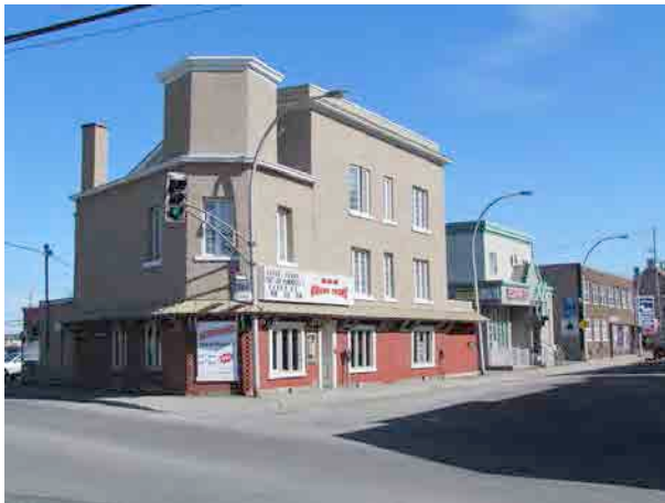
Ensemble d'édifices à fonction mixte sur l'avenue Laframboise, à l'intersection de la rue Sicotte. IMG_8438.jpg
